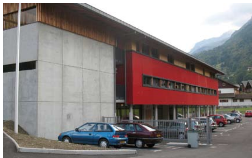
Groupe scolaire de Thônes
